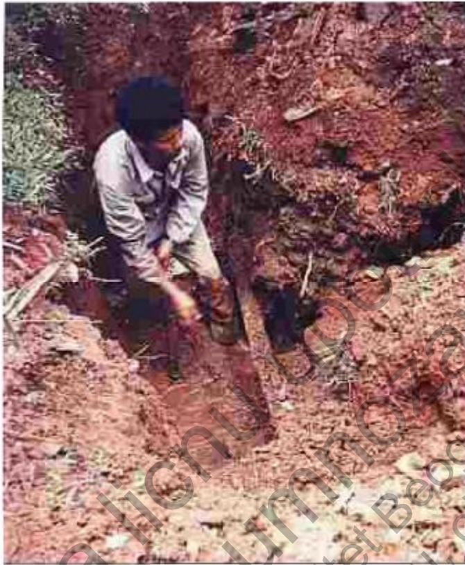
Slika F-9: Ručno iskopavanje
